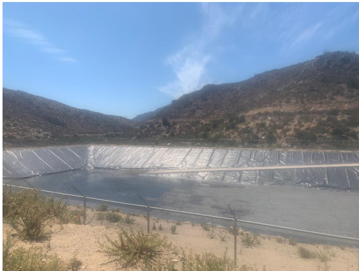
Imagen 2. Estado de ocupación de piscina de emergencia TK-11 el 4 de noviembre de 2021
