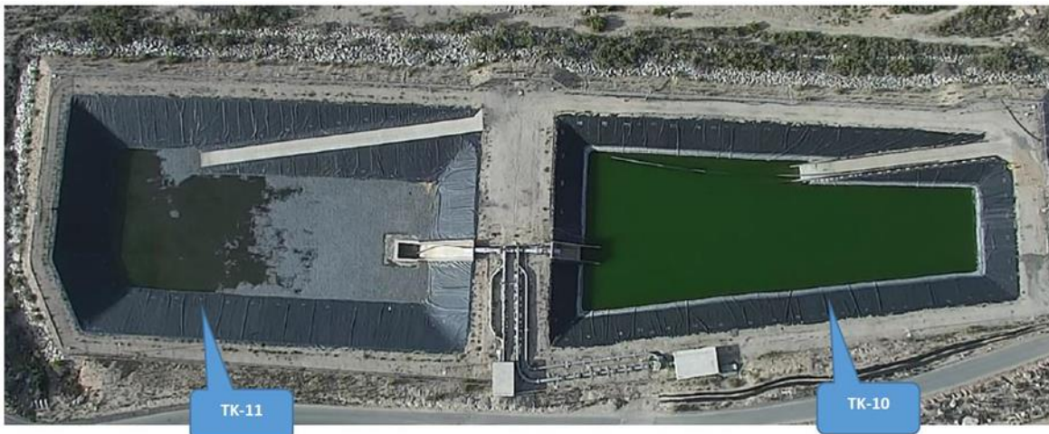
Imagen 1. Uso de piscinas de emergencia para almacenar aguas de proceso
