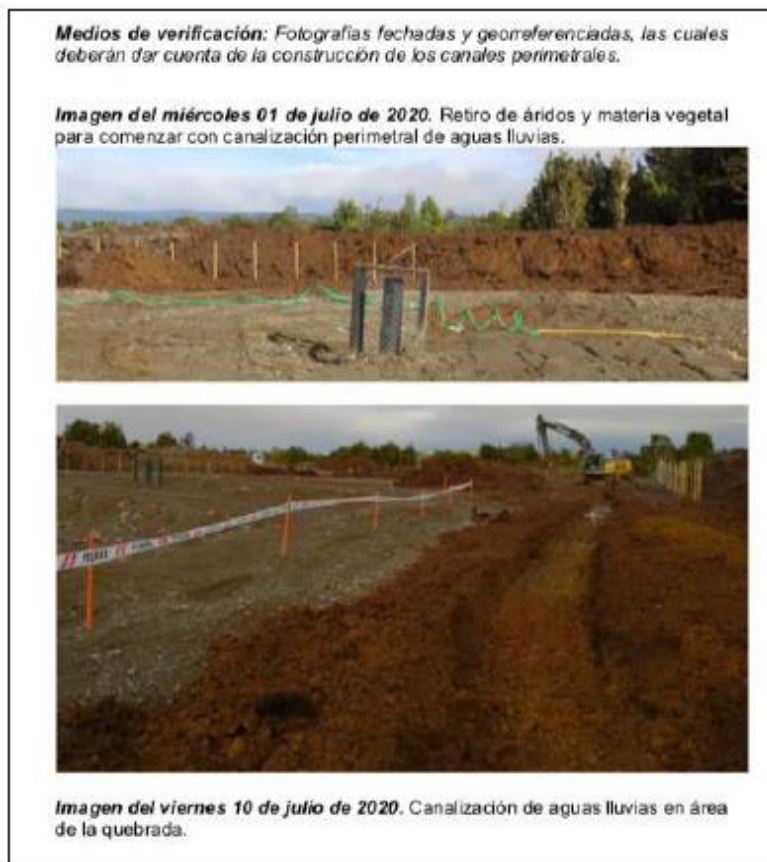
Imagen 4. Retiro de áridos y material vegetal para construcción de canal perimetral de 01/07/2020 y canalización de 10/07/2020
