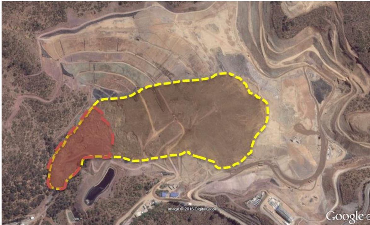
FIGURA 24. IDENTIFICACIÓN DE LA ZONA DEL DESPLAZAMIENTO
