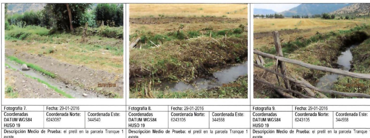
Imagen 9. Pretil construido en Tranque 1
