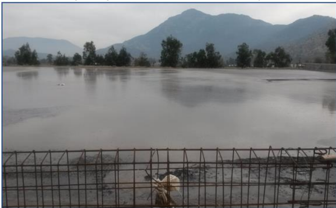
Imagen 4. Laguna anaeróbica colmatada de residuos líquidos
