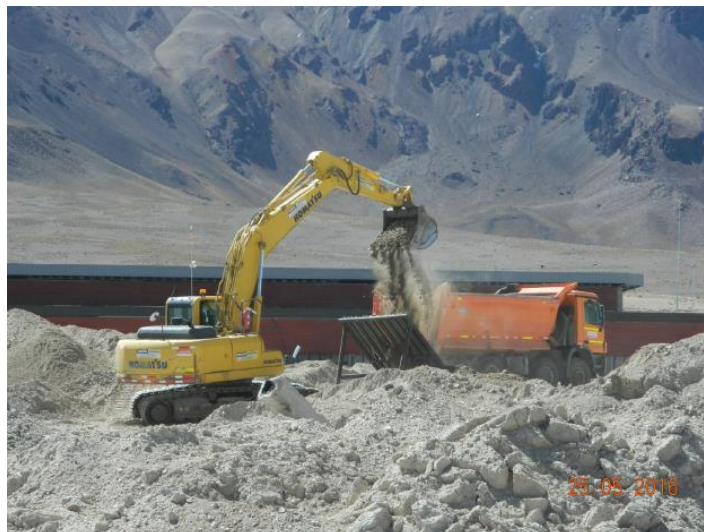
Imagen 7. Excavadora cargando con material estéril a camión tolva
