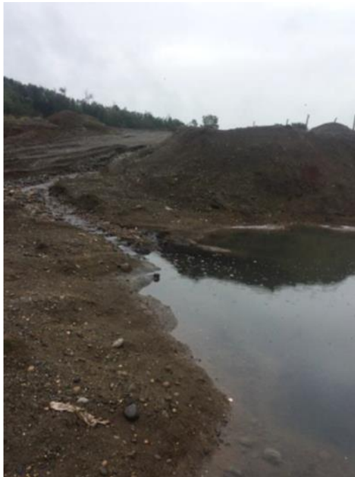
Imagen 11. Acumulación de lixiviados, mezclado con aguas lluvias, julio 2018
