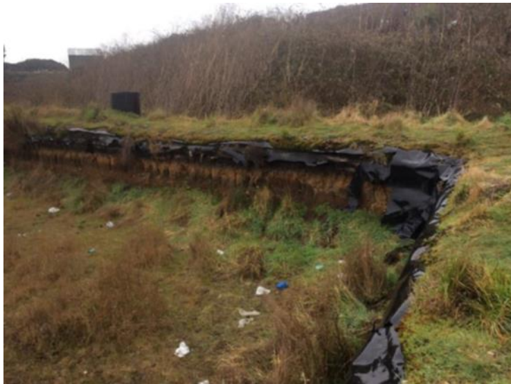
Imagen 7. Piscina de regulación sector noroeste, septiembre 2018
