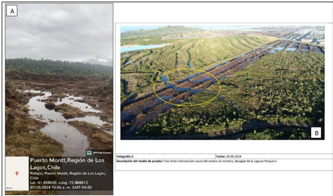
Figura 20. Fotografías de obras de intervención de cauce
