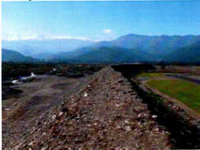
Fotografía N°1: Talud sector norte del Autódromo, parte superior.
