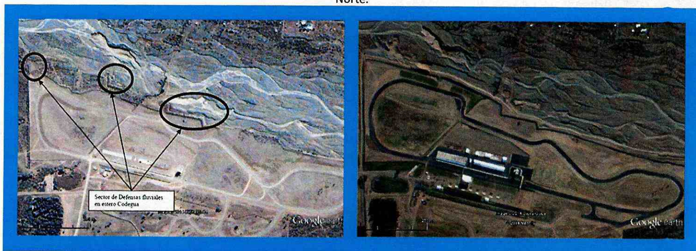
Imagen N°8 Comparación del sector de las barreras fluviales, antes y después de la construcción el Talud Norte.
