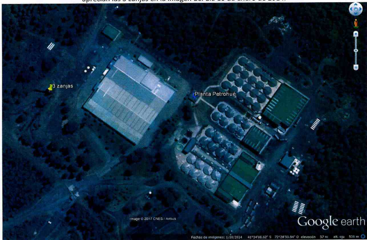
Imagen N° 1. Ubicación de las coordenadas 41°14'08.5 LatS; 72°28'49.1 LatW en Google Earth® donde se aprecian las 3 zanjas en la imagen del día 10 de enero de 2014.
