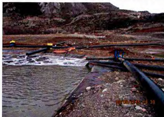
Fotografía 3 , instalación válvulas By pass
