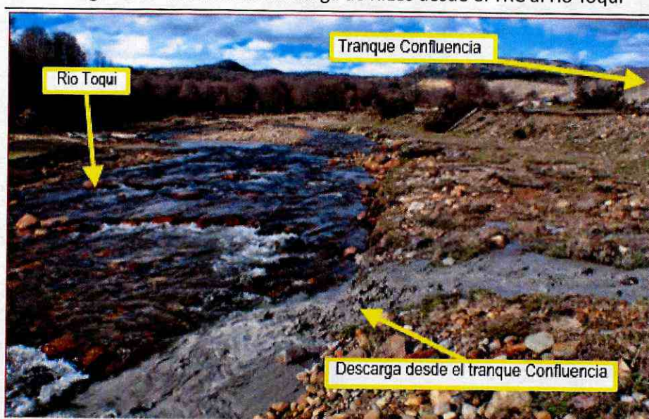
Fotografía 8 Fecha : 30 de septiembre de 2014 Punto en el cual el efluente líquido, proveniente desde las piscinas de decantación del tranque Confluencia, descarga al río Toqui.
