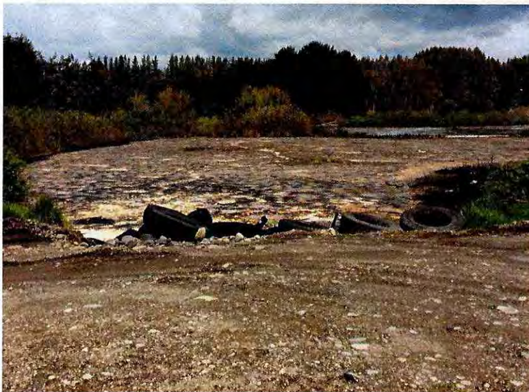
Imagen N° 5: Vista de la laguna 3, con neumáticos en su deslinde.
