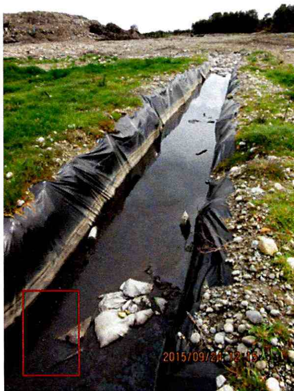
Fotografía N° 27: Reiteración de lo constatado en la inspección de octubre de 2014 (fotografía 24 de la presente resolución). Acumulación de lixiviados contenidos en una zanja de dimensiones aproximadas a 12 x 1 mt, también se observa la presencia de burbujas en superficie, capturada con fecha 24 de septiembre de 2015.
