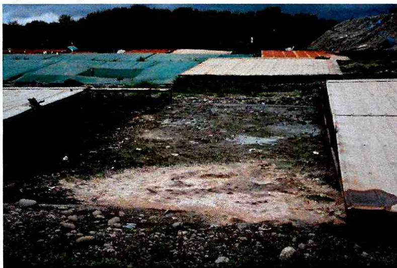
Fotografía N° 5: Zanja de lodos N° 1, falta de techo y estructura metálica de soporte que permite el ingreso de aguas lluvias, capturada con fecha 28 de octubre de 2014.
