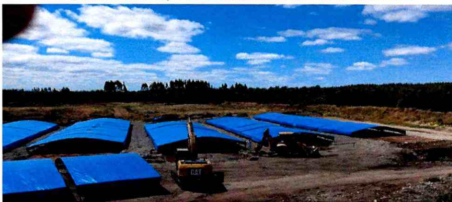
Fotografía n° 32: Zanjas de adecuación de lodos con techumbre.
