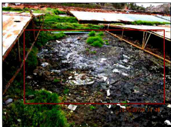
Fotografía N° 10: Zanja de lodos N° 2 falta de estructura de soporte y techo, capturada con fecha 24 de septiembre de 2015.
