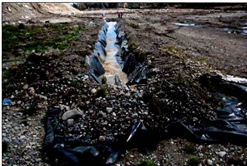
Fotografía N° 24: Presencia de lixiviados observados durante el recorrido del vertedero.
