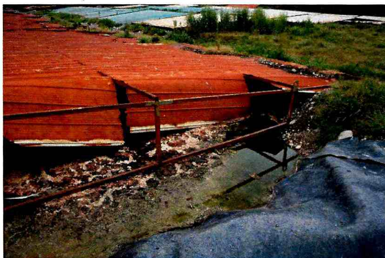
Fotografía N°6: Zanja N° 5 (en uso), mal estado del techo permitiendo el ingreso de aguas lluvias, capturada con fecha 28 de octubre de 2014.
