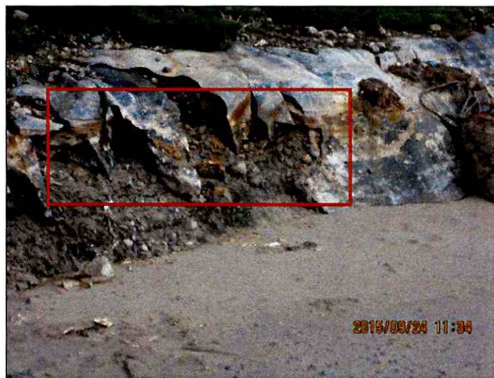
Fotografía N° 2: Rotura de material de impermeabilización en zanja de lodos N° 1, capturada con fecha 24 de septiembre de 2015.
