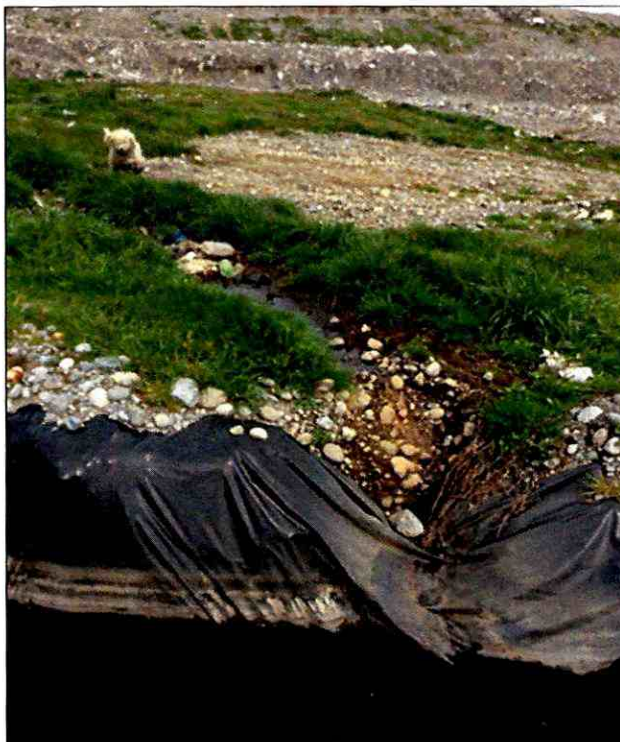
Fotografía N° 26: escurrimiento de percolados hacia la parte basal, capturada con fecha 24 de septiembre de 2015.
