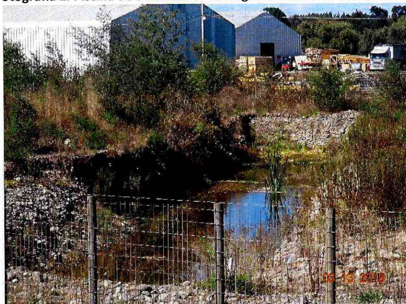
Fotografía 1. Piscina de decantación sin ingreso de riles ni recirculación.
