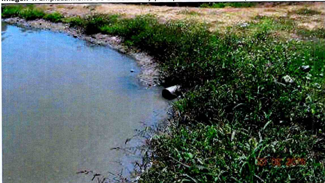
Imagen 4. Emplazamiento de entrada al by-pass por rebalse de nivel y sin válvula de control.
