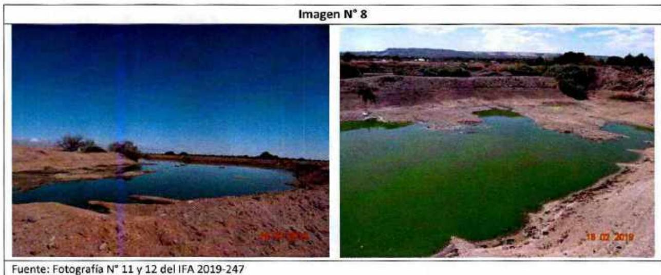
43. De la observación de las imágenes es dable destacar que a la fecha de inspección aún se aprecia líquidos acumulados al interior de las piscinas, a pesar de haber sido dejadas sin funcionamiento según información entregada por el titular. Adicionalmente, no se visibiliza ningún tipo de impermeabilización.
