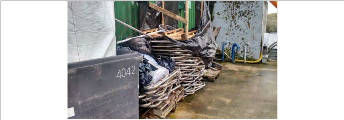
Imagen N° 17: Acopio de mangueras y 34 difusores al costado del pontón alimentador
