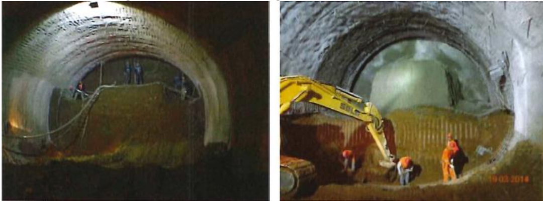
Imagen N° 3 – Sección hormigonada frente de excavación
