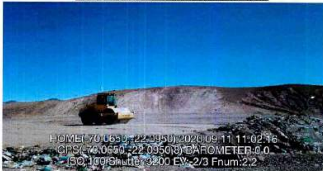
Imagen N° 3 – Residuos no compactados ni cubiertos.
