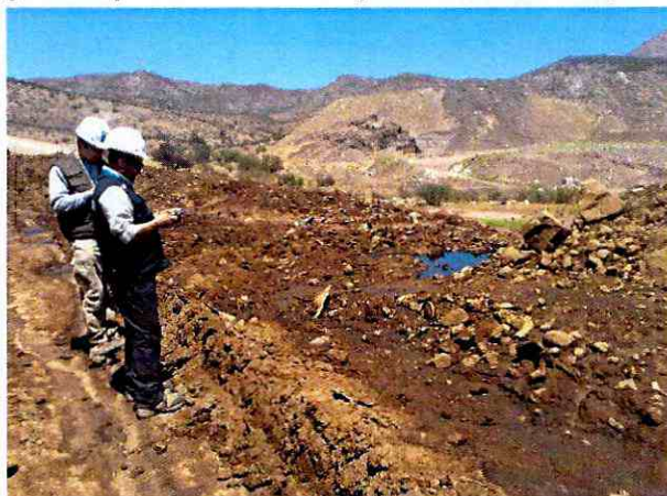
Imagen 1. Apozamientos de líquidos en caminos y taludes
