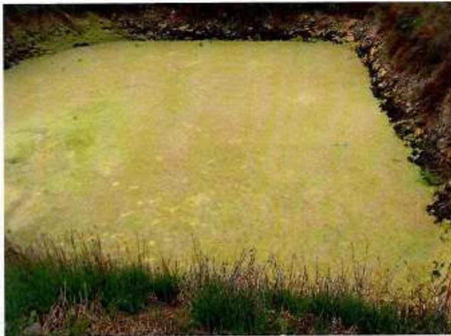
Imagen 2. Vista pozo de infiltración en uso.
