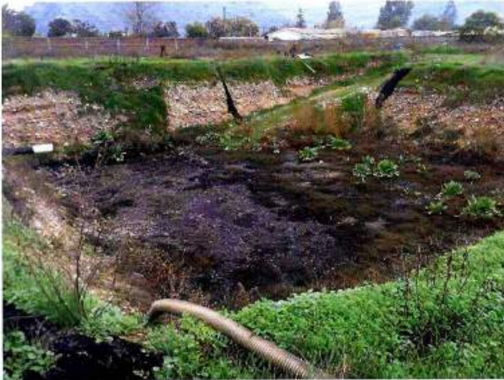
Imagen 1. Vista pozo de infiltración.
