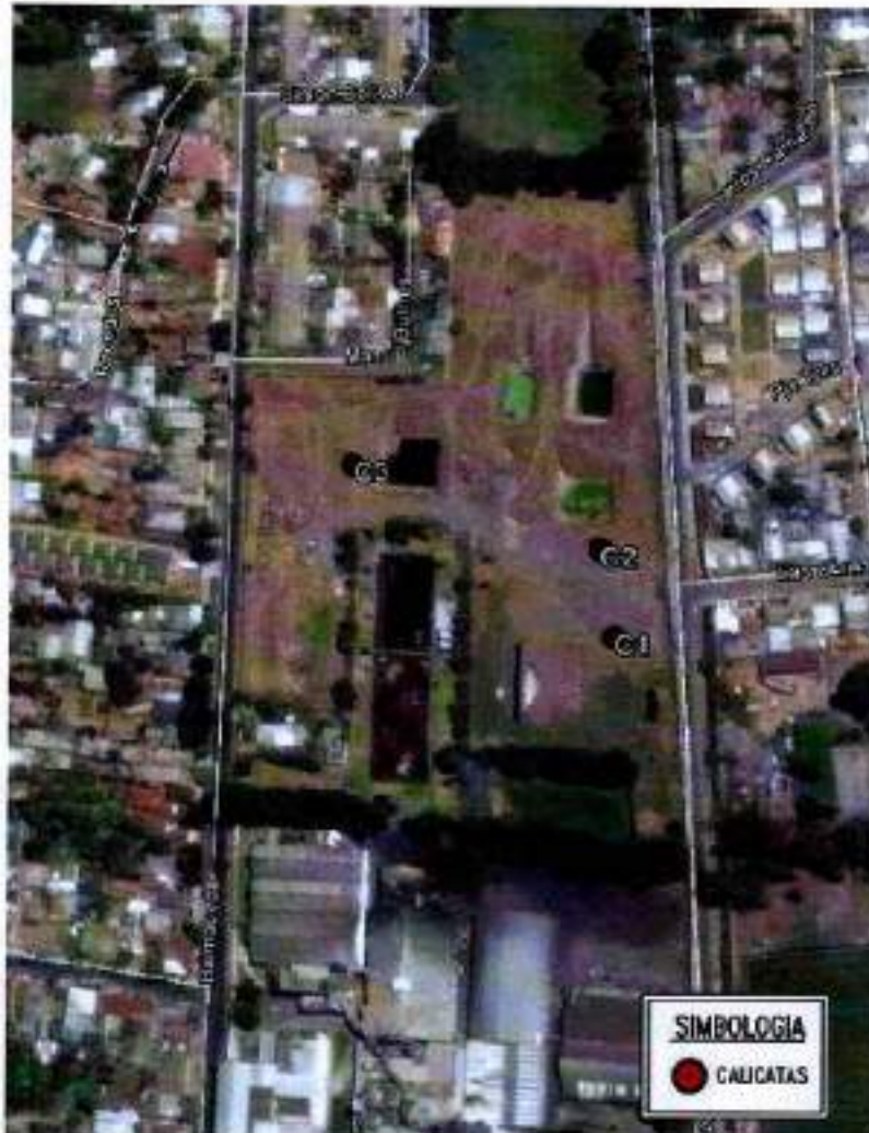
Imagen 3. Vista aérea pozos de infiltración.
