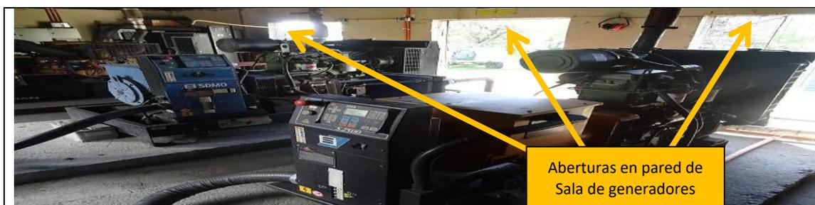
Ninguno de los generadores eléctricos disponibles contaba con gabinete de insonorización. Asimismo, se observan aberturas en pared (sin celosías) destinadas a la ventilación del recinto, además de la ausencia de material aislante acústico sobre la misma.
