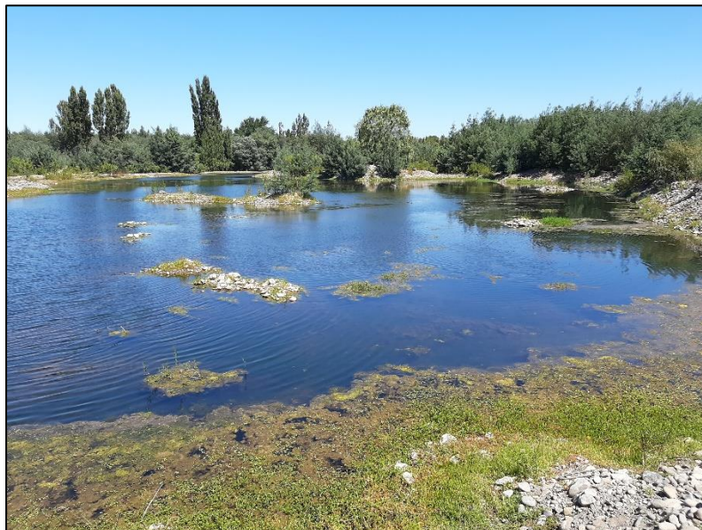
Imagen 1: Zona de extracción y apozamiento dentro del cauce que genera modificación de la sección transversal del río
