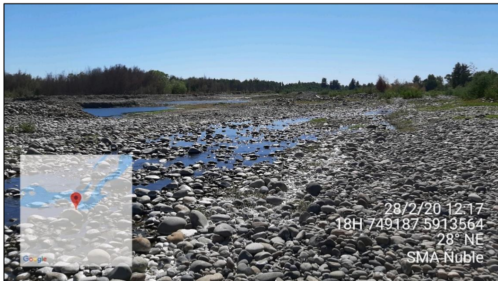
Imagen 3: Pérdida de continuo hídrico en ribera sur del río asociado a las obras de desvío, pretil y apozamientos en la zona norte del cauce
