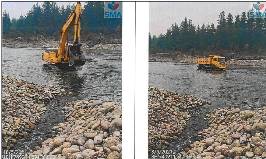
Imagen 4: Maquinaria excavadora el interior del cauce y vehículo de carga en atravesado del río
