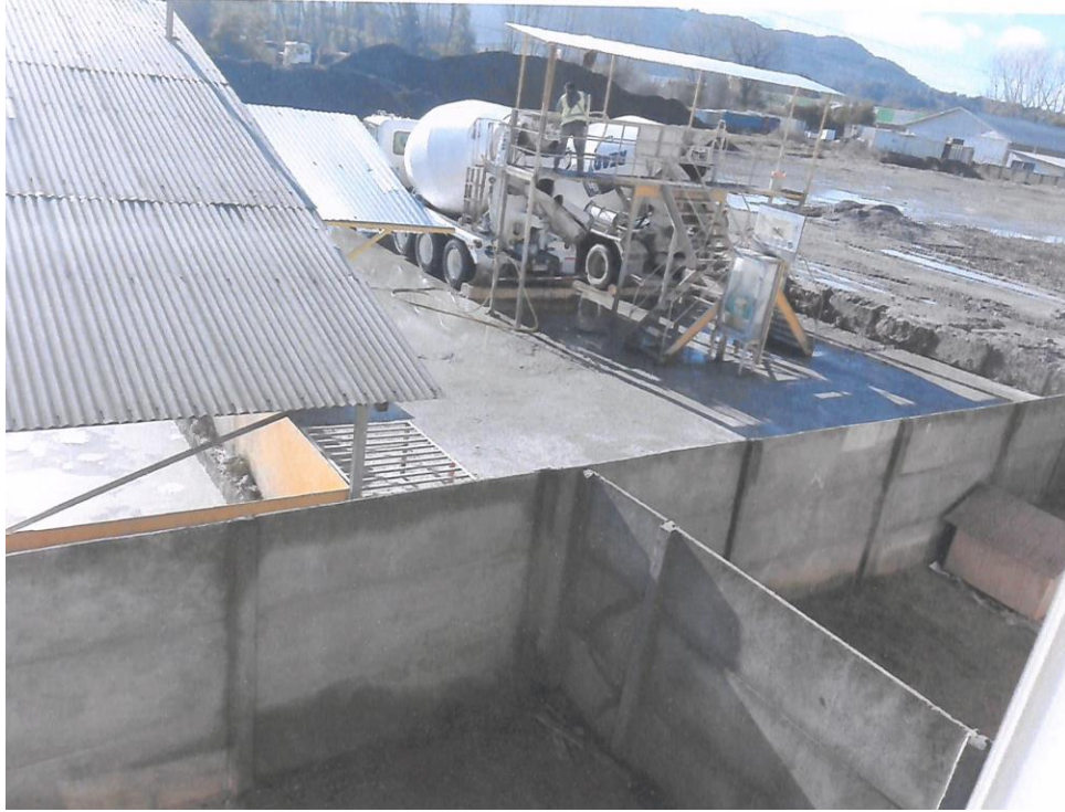
Fotografía N° 1. Vista a UF Valdicor desde vivienda de Sabine Riquelme
