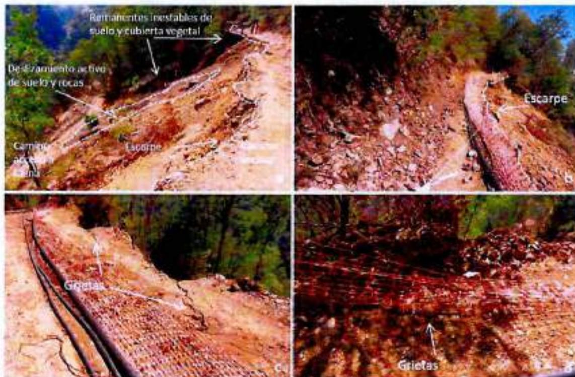
**Figura 5: a) y b) Escarpe de remoción en masa que destruyó totalidad de tramo del camino vecinal. Imágenes de los depósitos de deslizamiento de suelo y rocas se observan en vista desde camino de acceso a faena, se detallan en la siguiente figura. c) y d) Grietas extensionales en bordes del escarpe evidenciando alta inestabilidad en camino vecinal. Sector vulnerable a generar nuevos deslizamientos.**
