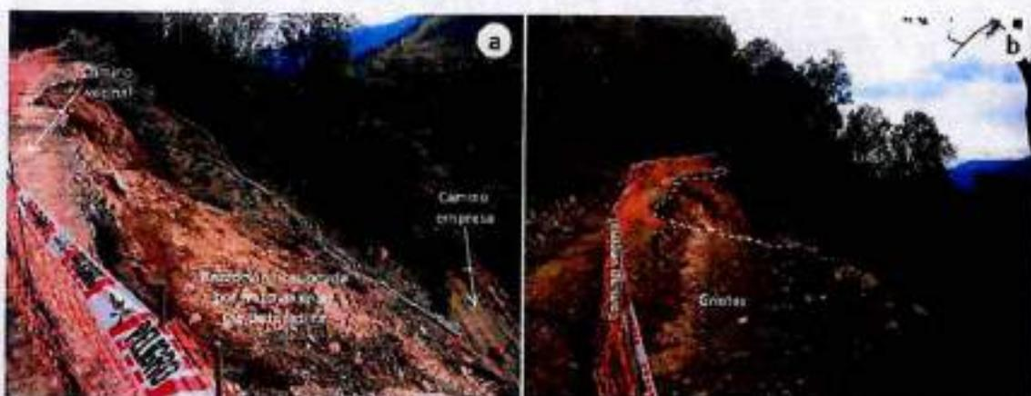
**Figura 10. Cabera de deslizamiento en camino vecinal. a) Se observa en línea punteada el escarpe activo que se originó tras la remoción de material. b) detalle de las grietas de tracción.**
