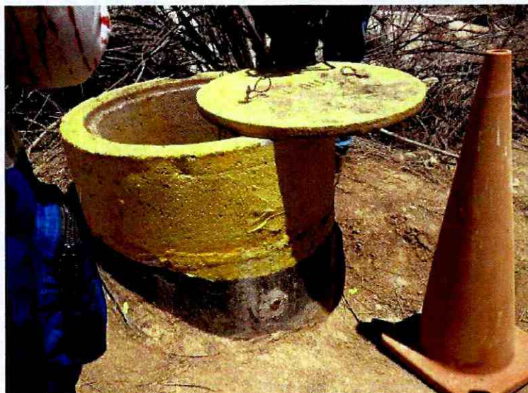
Imagen 6. Cámara de inspección de piscina TK-10
