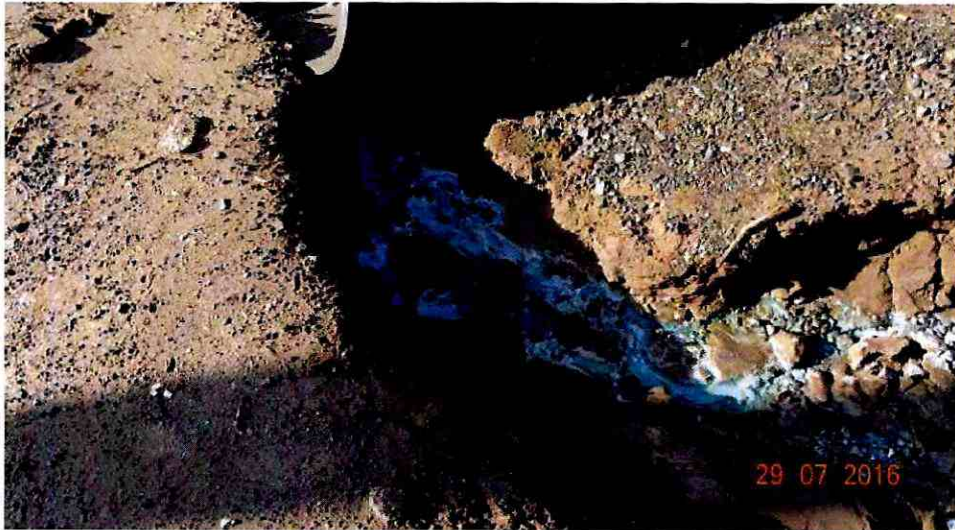
Imagen 9. Canaleta de aguas lluvias con líquido y sedimento de coloración verdosa.
