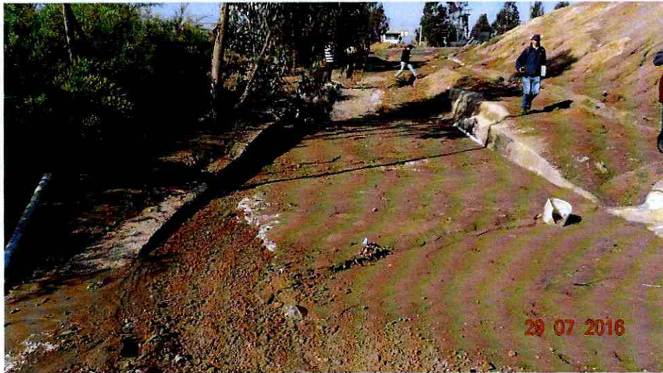
Imagen 7. Pozo de recolección de aguas lluvias sector norte embancado con arena.
