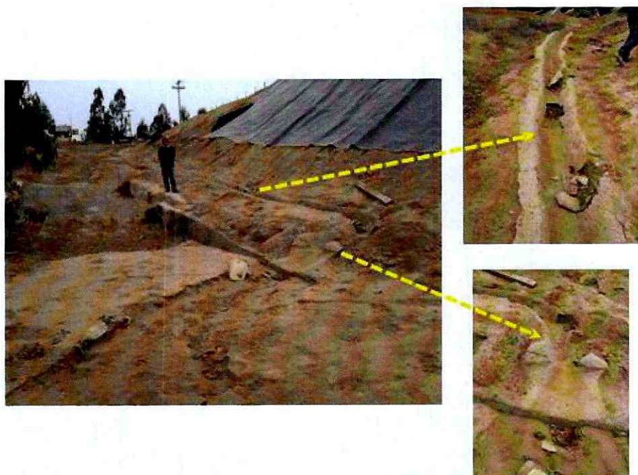
Imagen 5. Canaleta conductora de aguas lluvia deteriorada.
