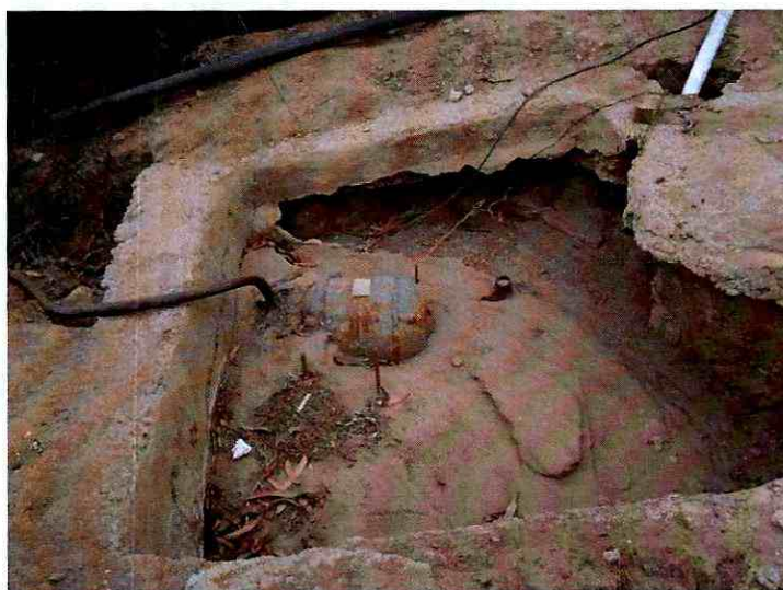
Imagen 6. Bomba de impulsión embancada.
