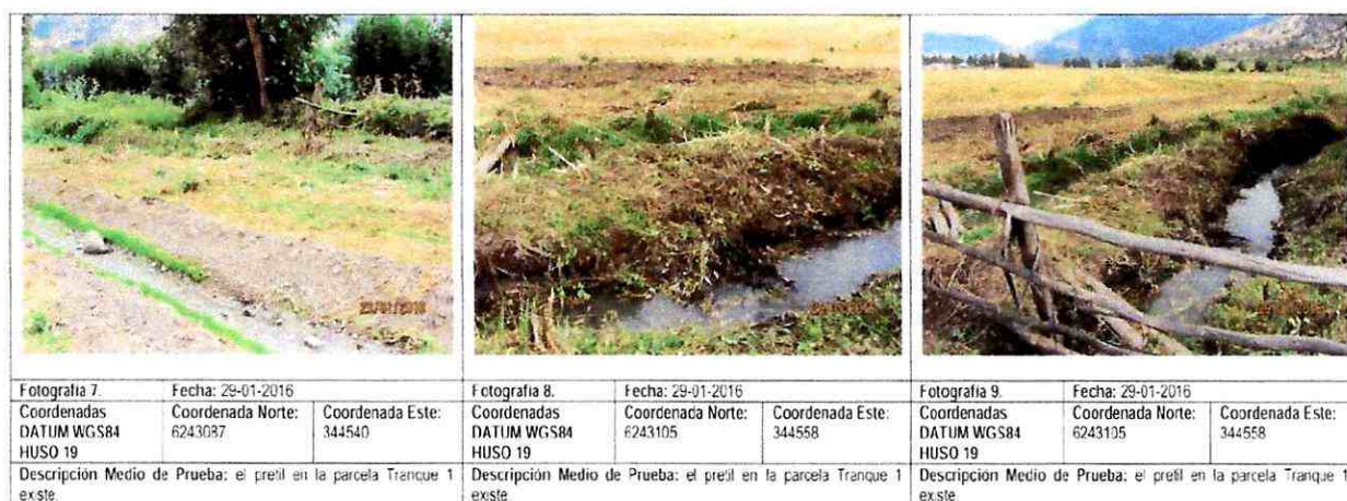
Imagen 9. Pretil construido en Tranque 1
