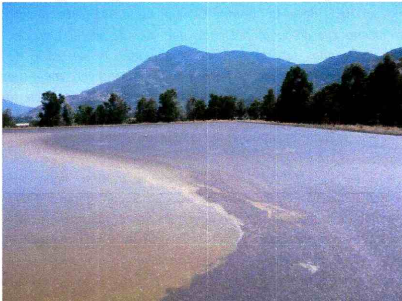
Imagen 3. Laguna anaeróbica con lodos en la superficie.
