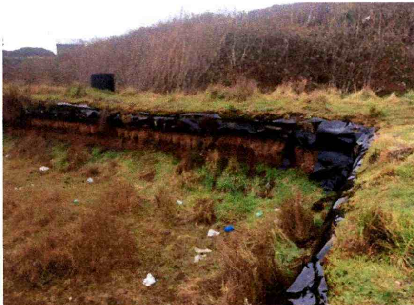
Imagen 6. Piscina de regulación sector noroeste
