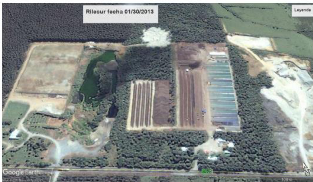
Ilustración 7. Estado del predio a 30 de enero de 2013
