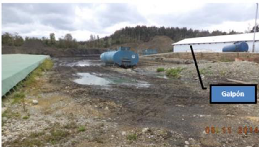
Fotografía 3. Zanja de co-digestión N° 17 sin canal longitudinal de aguas lluvias
