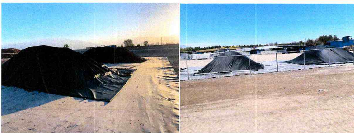
Figura 9. Canchas de secado de lodos
