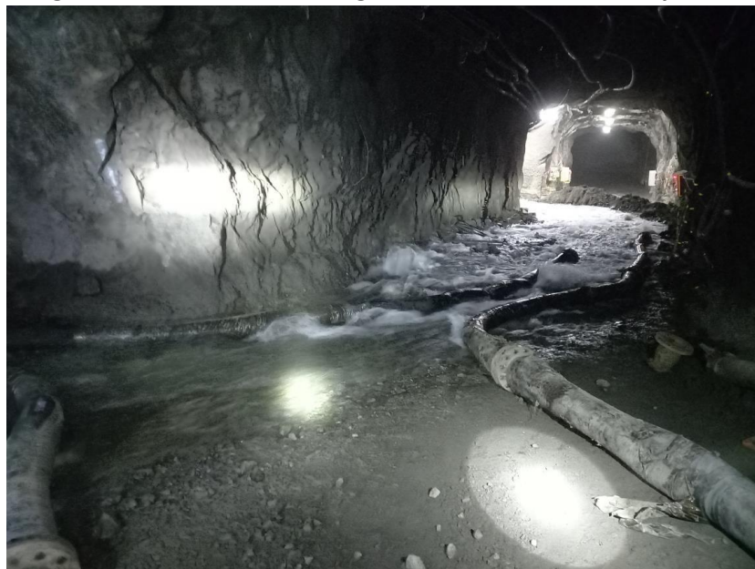
Figura 50. Esguerrimiento de agua al interior de Mina Alcaparrosa
