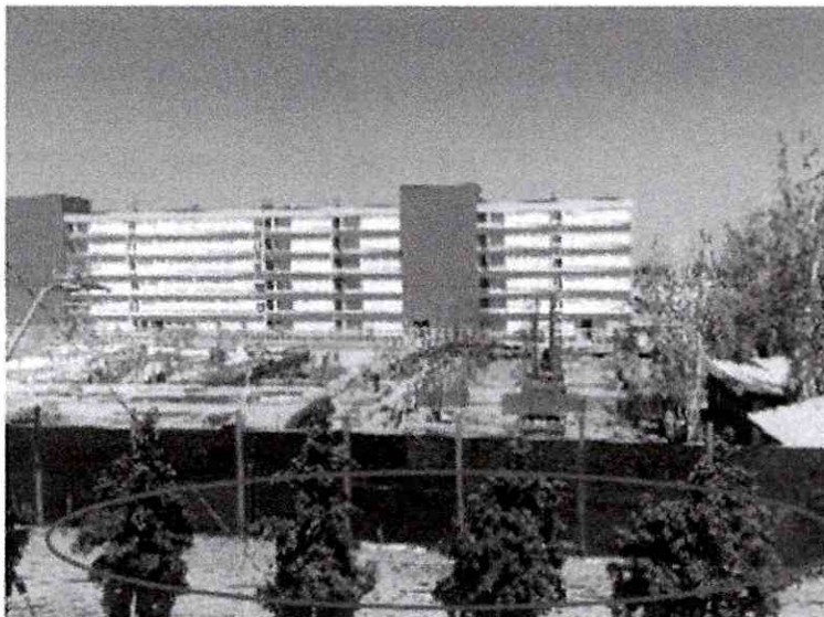
Imagen 2. Cierre perimetral, vista desde costado oriente
