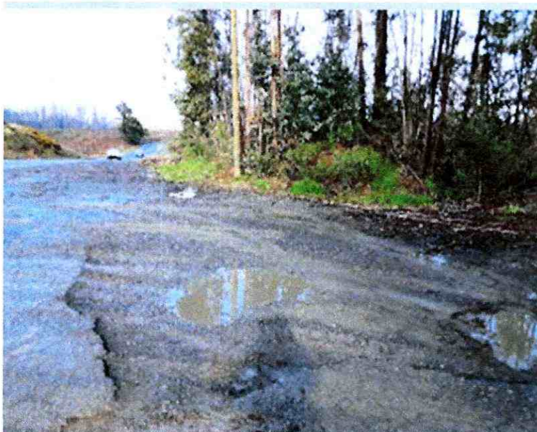
Figura 11. Empalme con asfalto deteriorado
