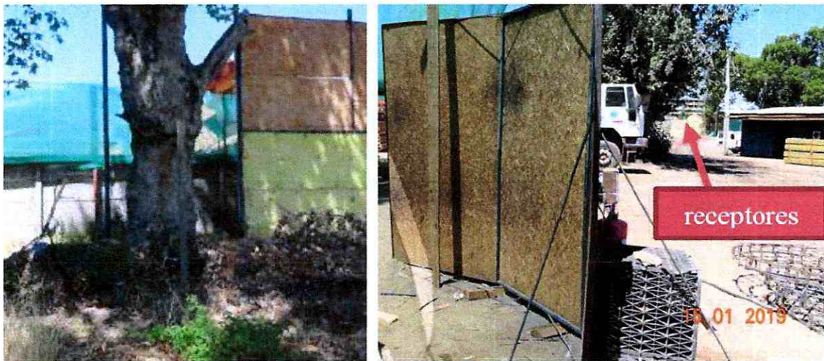
Figura 4 Barrera acústica y pantalla acústica
