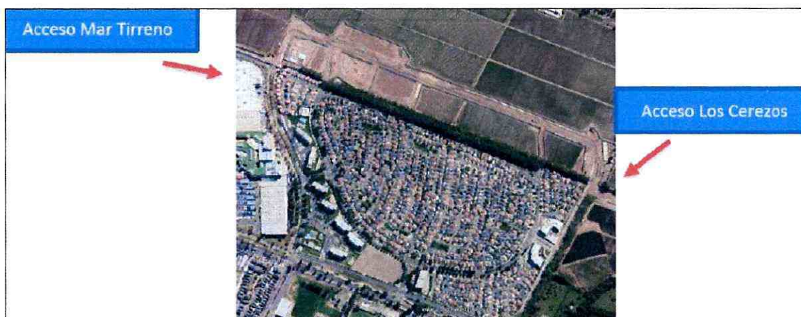
Figura 5. Accesos a la faena de la unidad fiscalizable
