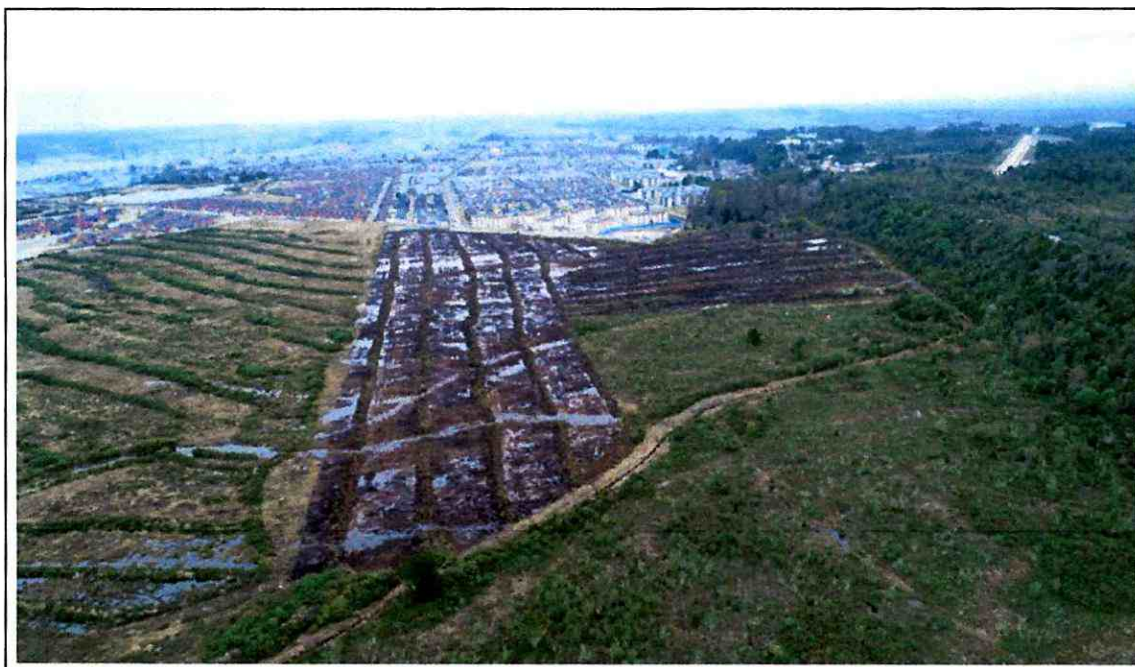
Imagen 1. Intervención efectuada por Inmobiliaria Rossan Ltda, 10 de julio de 2024
