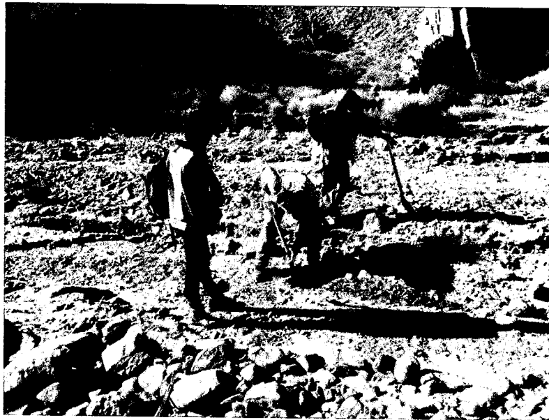
Figura 2. Calicatas realizadas en distintos puntos a lo largo de los Tramos.
