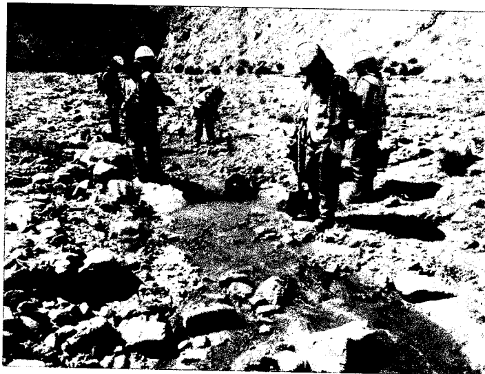
Figura 3. Aspecto de Inspección y Limpieza en Tramo 44.
