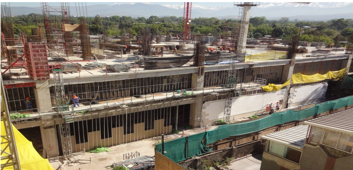
Ejecución de cierre duro y retiro de cierre provisorio acústico de OSB.
