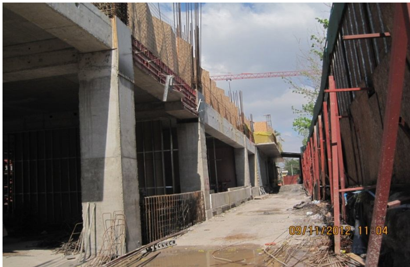
FOTO 1 Cierre Acústico continuo realizado por calle Hannover.
