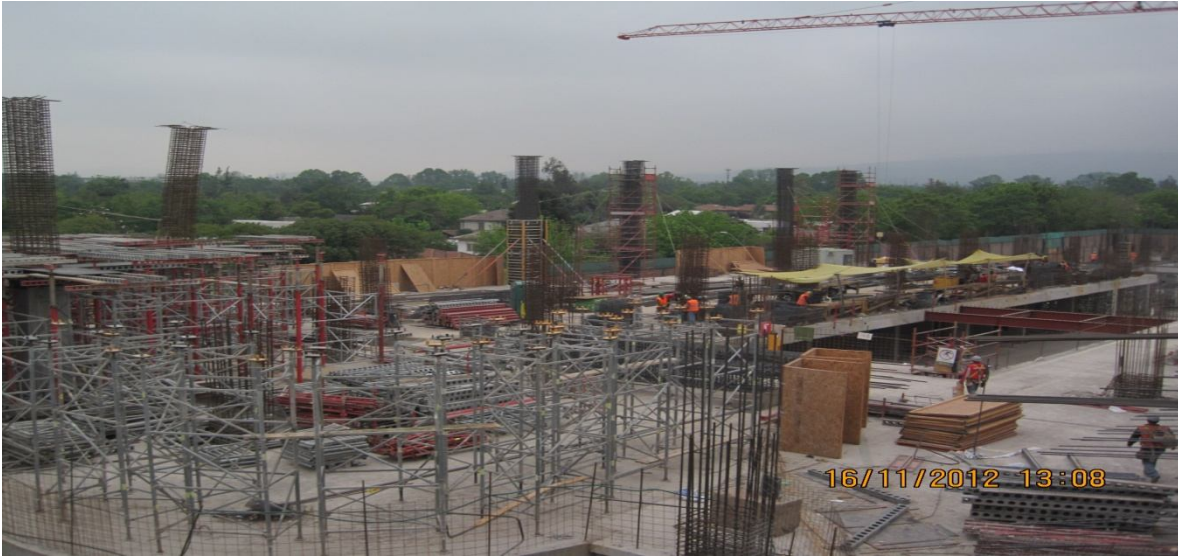
FOTO 2 Trabajos de hormigonado de losas y pilares al interior del perímetro de calle Hannover, se observa cierre perimetral continuo.
