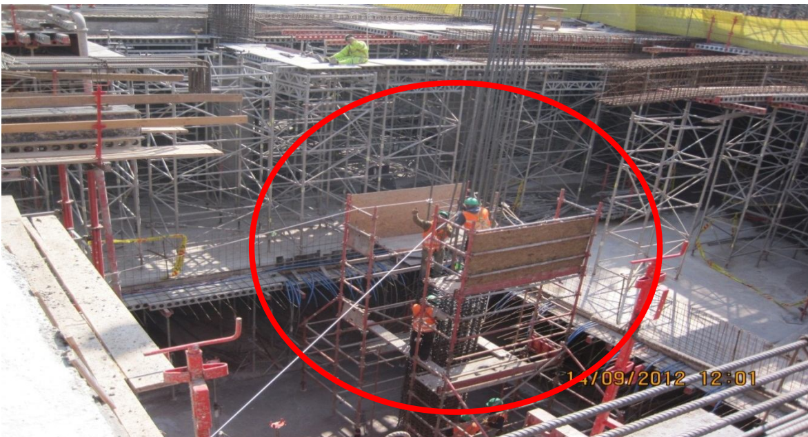
FOTO 3 Hormigonado de pilares al interior del perímetro con cierre OSB con el fin de atenuar las emisiones de ruido.
