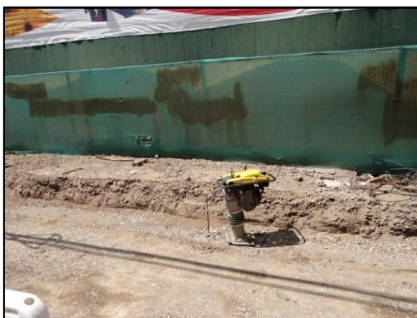
FOTOGRAFÍA 17 IIA, COMPACTADORA EN PISTA ADICIONAL ACCESO CALLE HANNOVER, INFORME DE INSPECCIÓN AMBIENTAL
