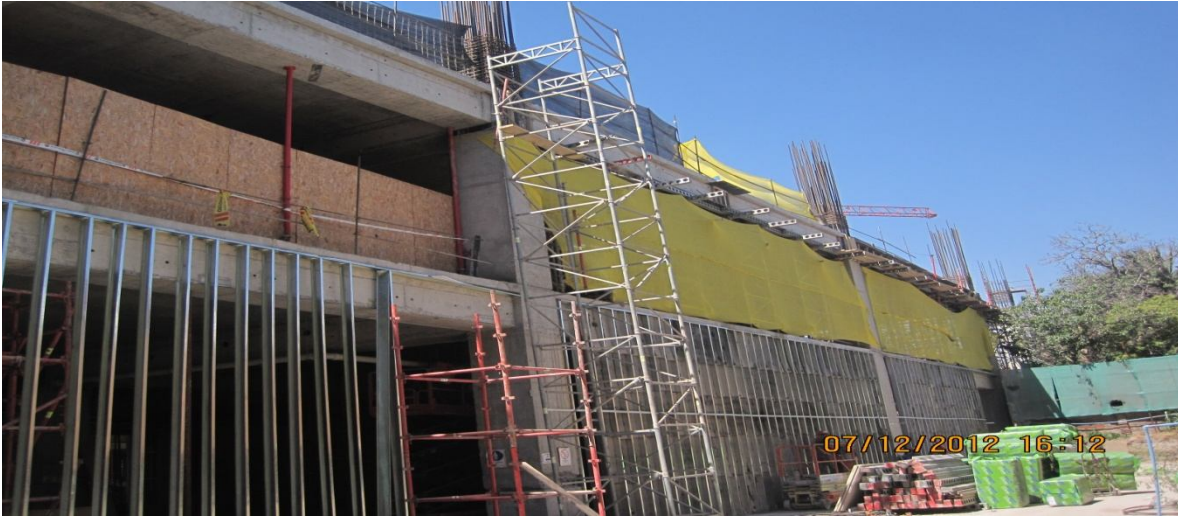
Ejecución de cierre duro y retiro de cierre provisorio acústico de OSB.
