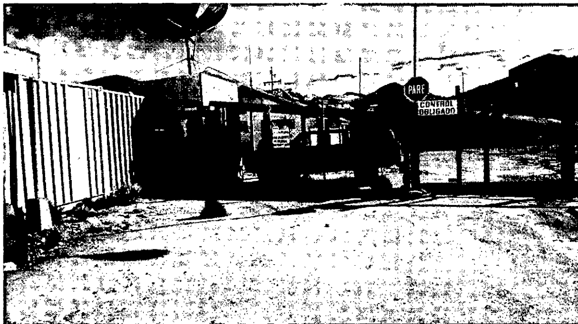
Foto 1 Acceso a faena minera Choquelimpie
