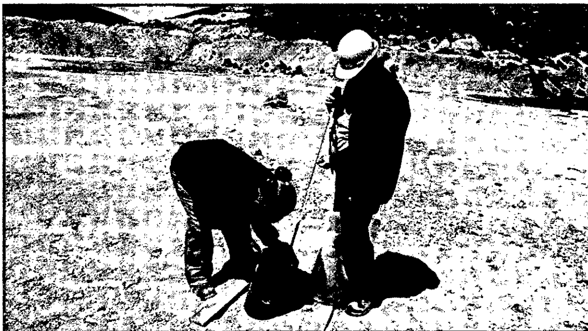
Foto 7 Se constata presencia de agua en sondaje 2, fiscalizador mide la profundidad del nivel superior del agua, desde el tubo de HDP.
