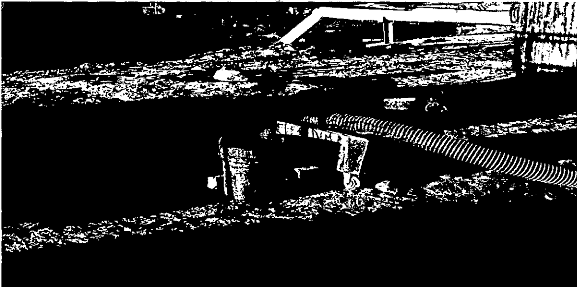
Línea flexible de descarga (Manguerote)
