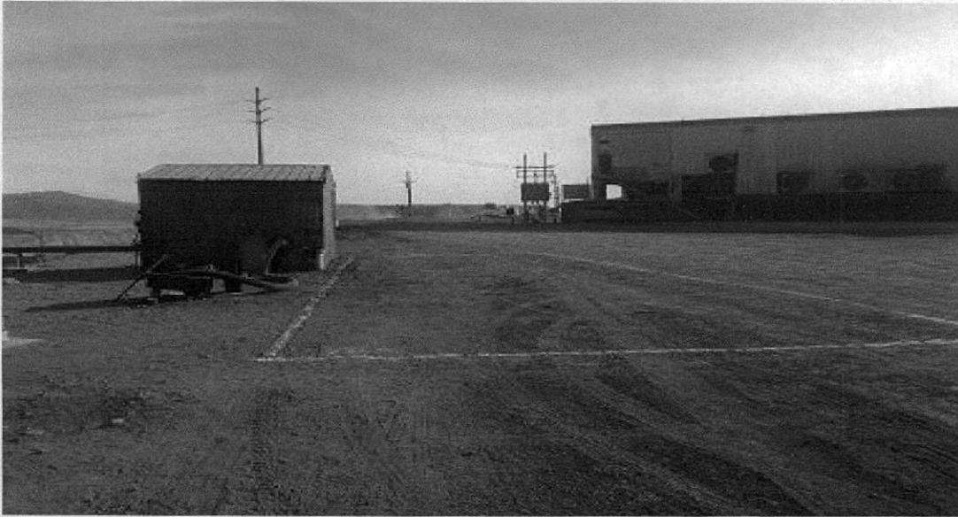
Foto N° 1: Se fija perímetro donde se construirá suelo impermeable para la recepción de camiones de abastecimiento de HC
