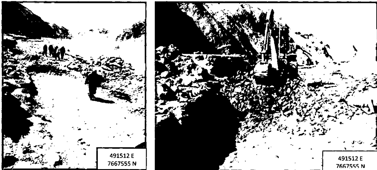
Figura 6. Realización de Calicatas en sector de paso de camino (Tramo 87). La foto superior izquierda muestra las dos calicatas en donde se observó presencia de HC.
