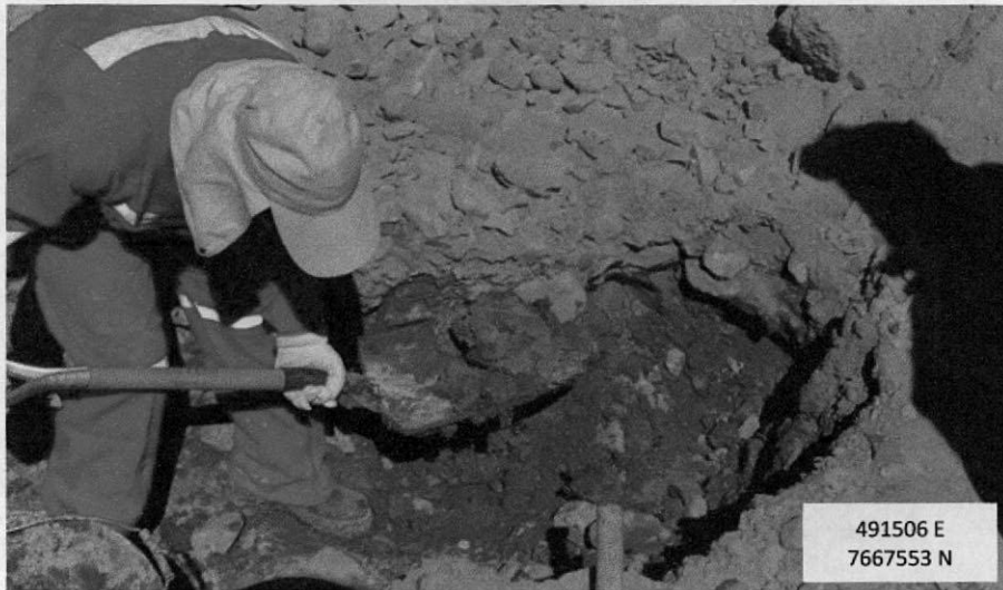
Figura 42. retiro manual de material impactado (gris)
