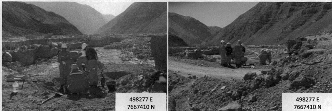
Figura 40. Retiro manual de material impactado en Paso I
