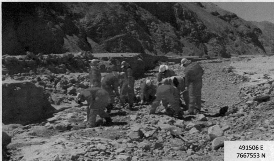
Figura 41. Despeje manual de rocas
