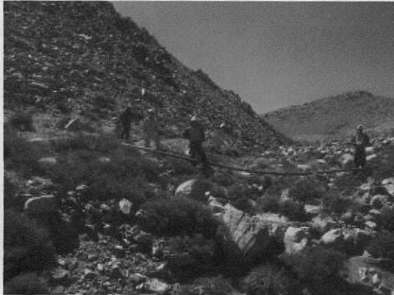
Fotografía 9: Tendido en falda de cerros, para evitar pasar por bofedales
