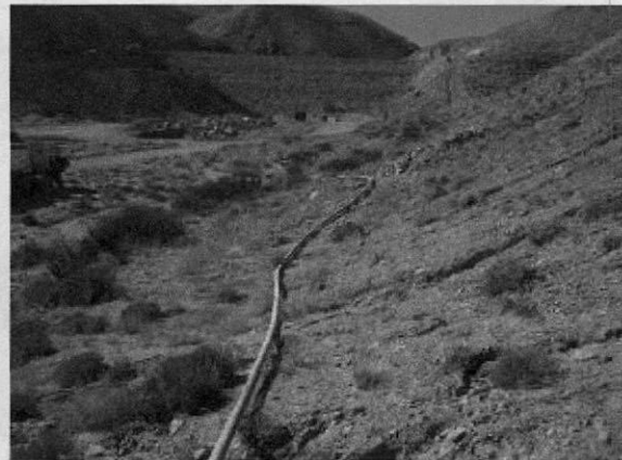
Fotografía 18: Tendido Línea HDPE
