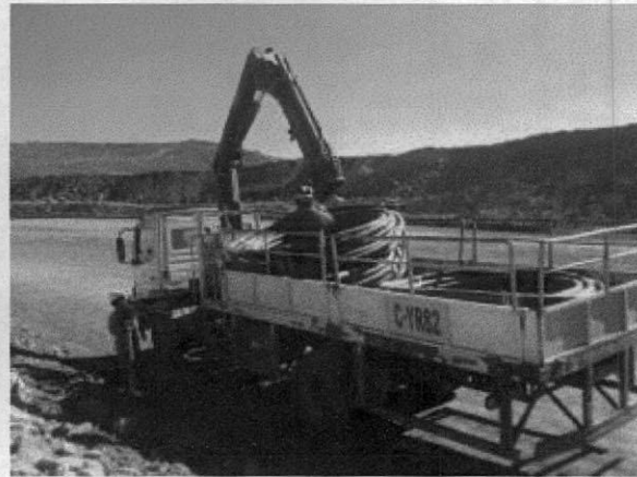
Fotografía 2: Traslado de tuberías desde bodega hacia punto de trabajos
