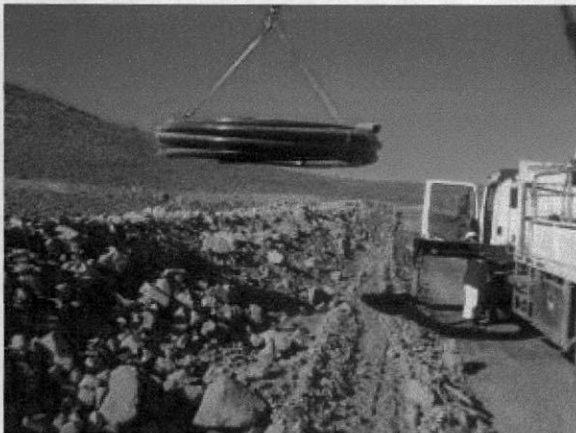
Fotografía 3: Posicionamiento de tuberías en punto de trabajo
