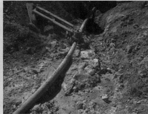
Fotografía 22: Válvula corte principal (inicio tendido tubería)
