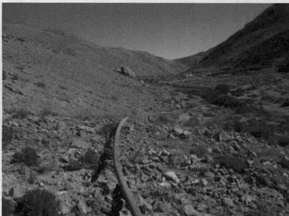
Fotografía 17: Tendido en la falda de cerros para evitar bofedales
