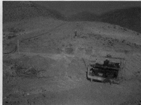
Fotografía 10: Trabajos de tendido HDPE
