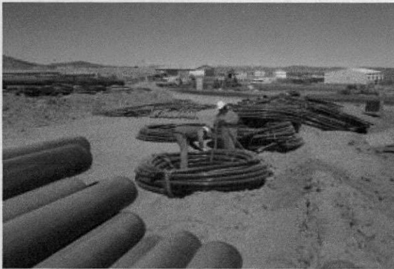
Fotografía 1: Retiro de Tuberías en bodega Teck
