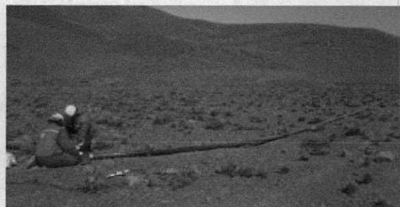
Fotografía 6: Termofusión de tuberías
