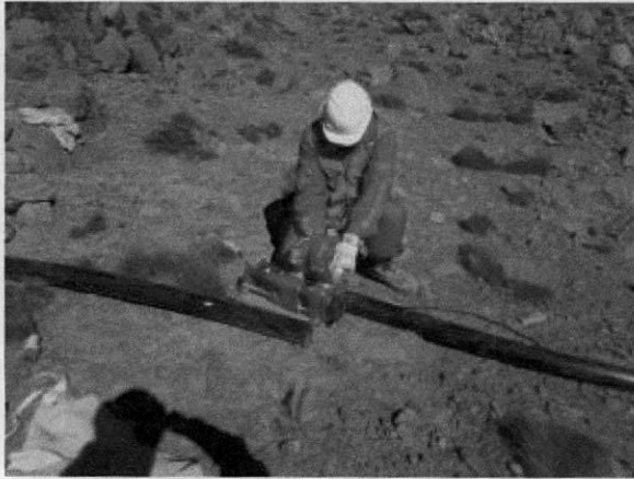
Fotografía 7: preparación para Termofusión de Tuberías
