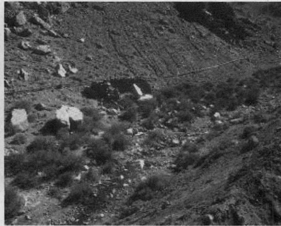
Fotografía 8: Tendido HDPE evitando flora del lugar
