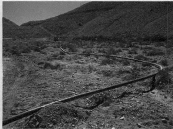
Fotografía 16: Tendido de Línea HDPE
