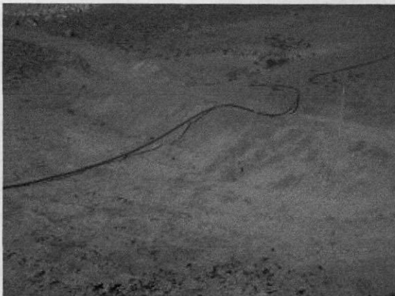
Fotografía 11: Línea de HDPE en cruce camino
