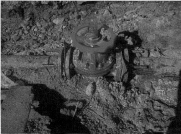
Fotografía 19: Instalación a Válvula de corte
