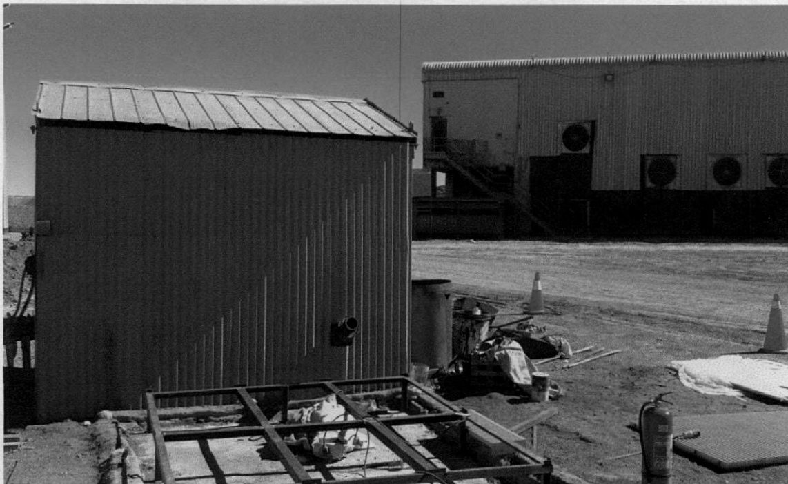
Imagen N° 1.- Avance de ubicación de línea flexible de descarg
