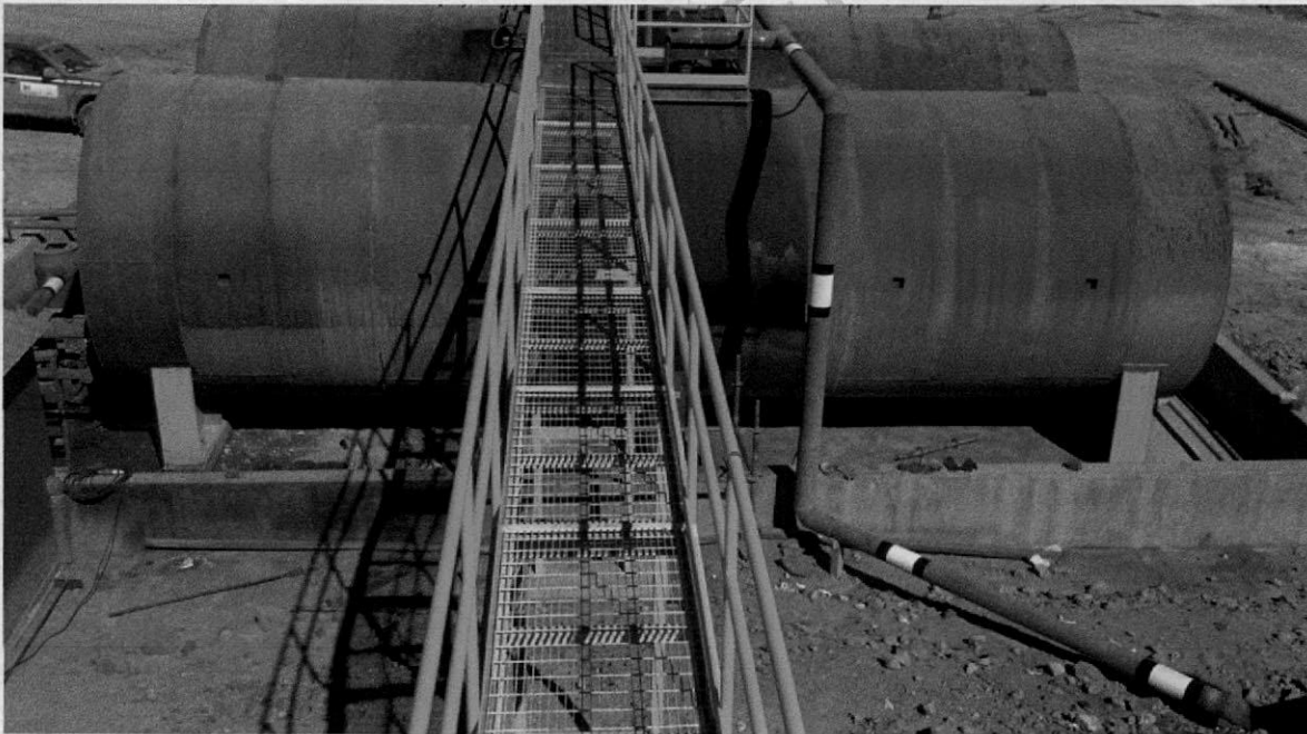
Imagen N° 4.-Limpieza y pintura de líneas sobre nivel.
