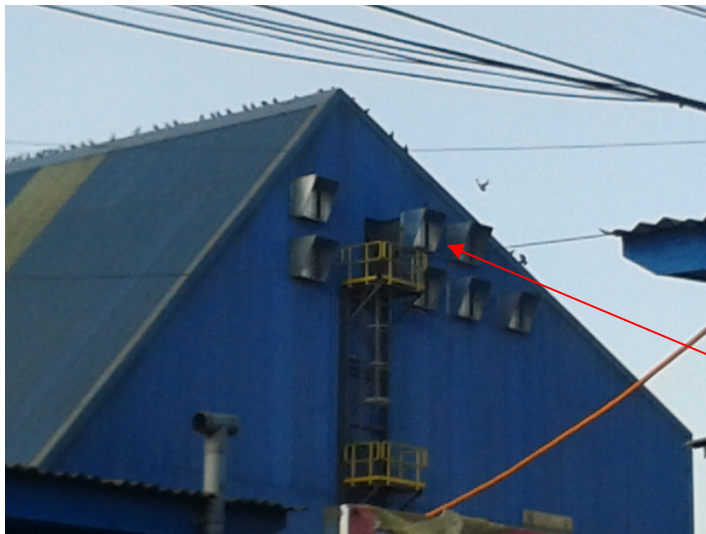
FOTOGRAFIA 5.1 VISTA DE CELOSÍAS GRAVITACIONALES BODEGA N° 1
