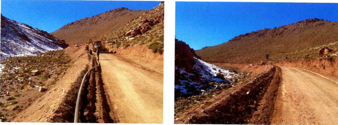
Fotografías N° 3 y N° 4: Cubrimiento de la Tubería.
