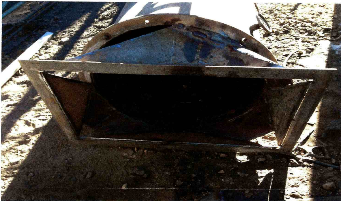
Imagen N°11 : modificación y fabricación ensamble de chimenea
