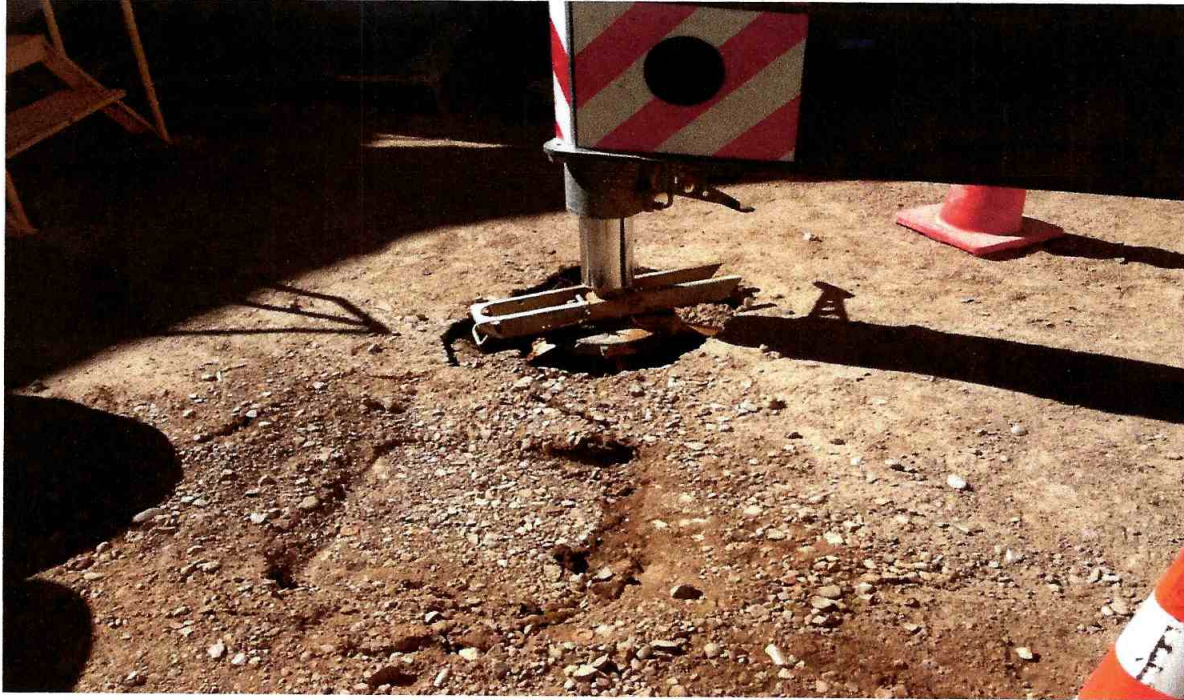
Imagen N°19: terreno blando para realizar retiro de calentador N°1
