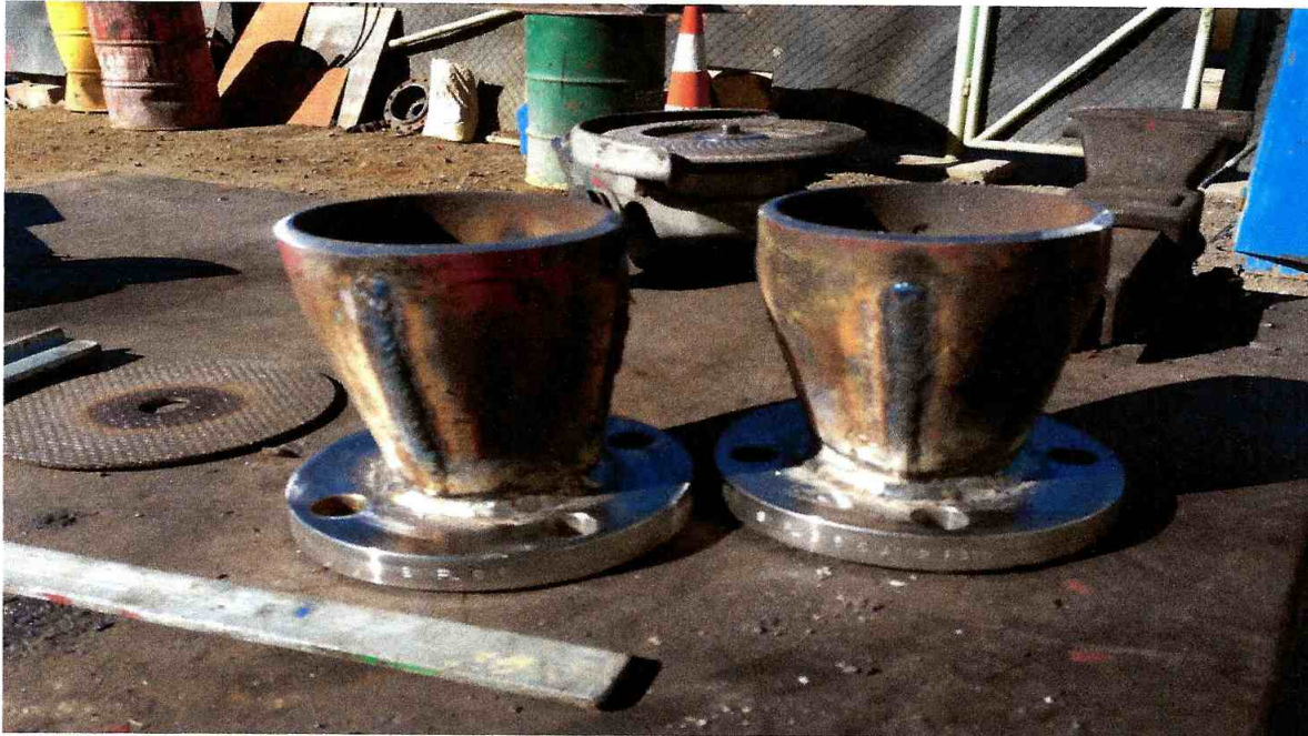
Imagen N°13 : modificaciones ,reducciones carretes válvulas de seguridad
