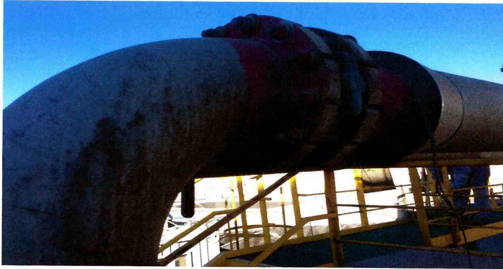
Imagen 1: retiro lana mineral, lata aislación y pernos en general
