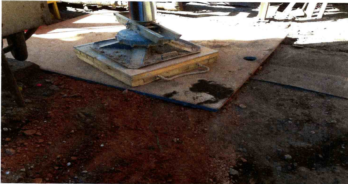
Imagen N°20: relleno y estabilizado de terreno posicionamiento de planchas
