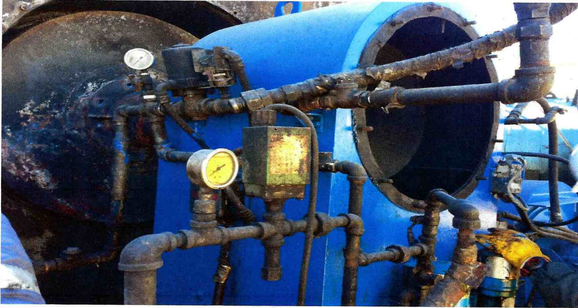
Imagen N°8 : retiro de carrete conexión, caparazón quemador y conjuntos en general
