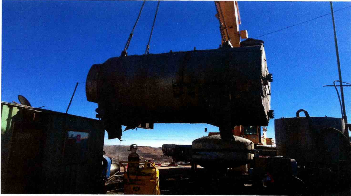
Imagen N°10 : retiro de calentador N°2
