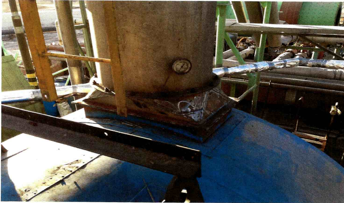
Imagen N°17 : modificación e instalación de chimenea
