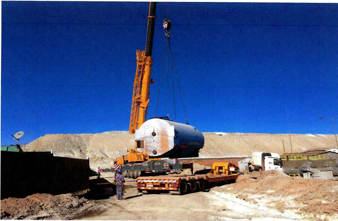
Imagen N°9 : traslado y descarguio de calentador nuevo
