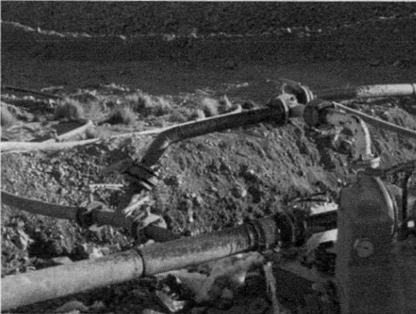
Fotografía N°2: Reparación de tubería.
