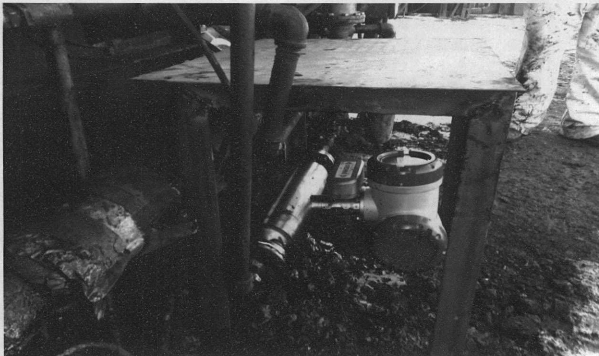
Imagen N°9: Instalación de flujometro en línea de retorno bancker de calentador N°2 de refino
