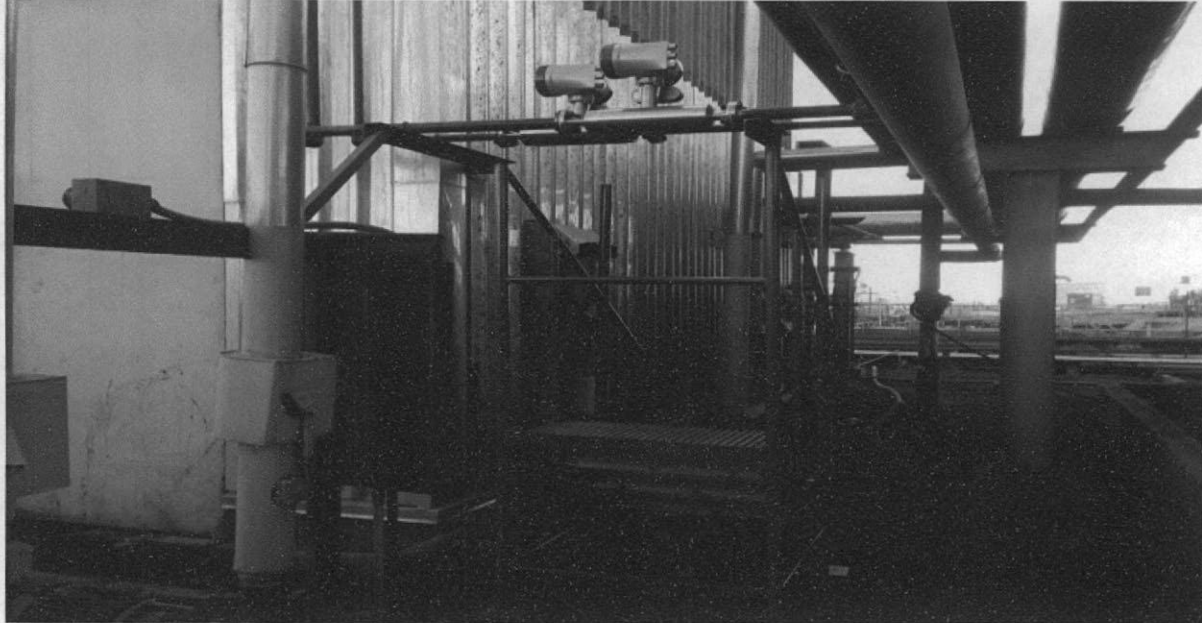
Imagen N°6: Instalación flujometros retorno bancker y retorno diesel calentador N°2 planta
