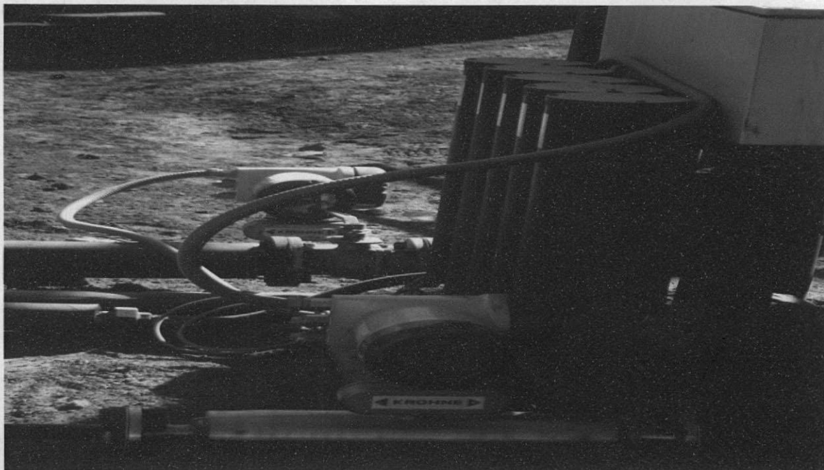
Imagen N°11: Instalación de dos flujometros retorno bancker y retorno diesel calentador N°3 de refino
