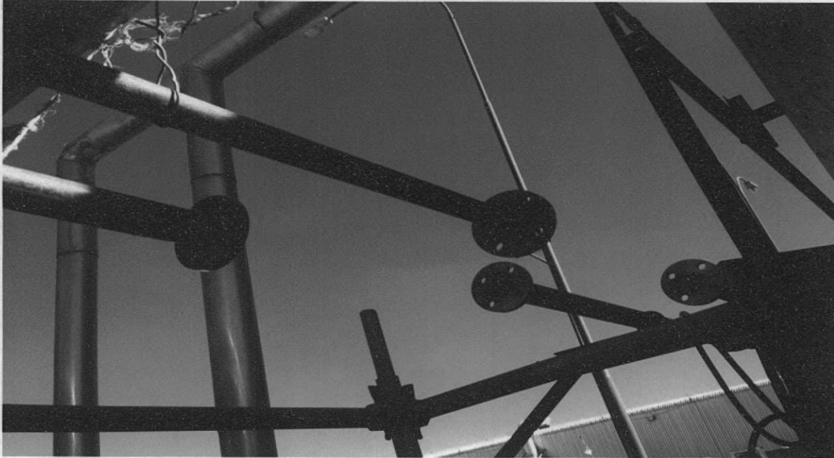
Imagen N°1: Corte de cañerías e instalación de flanges
