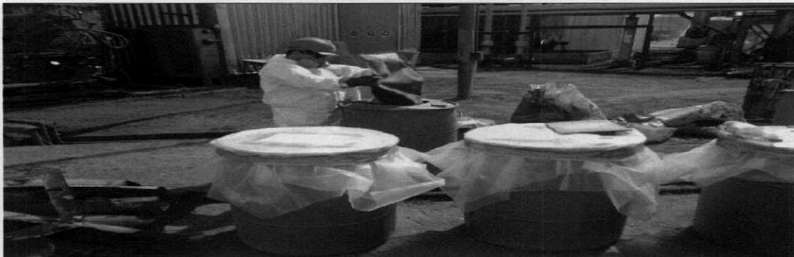
**Foto N°6:** Se almacena material contaminado en contenedores especiales y rotulados.
