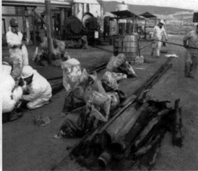
**Foto Nº2:** Cambio de tuberías el día 3 de Enero de 2013, producto de fuga de petróleo bunker en sistema de recirculación
